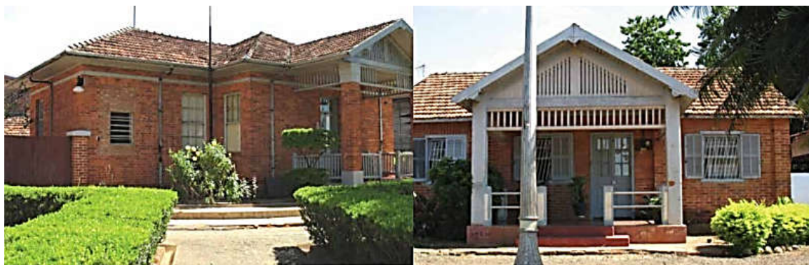
Figura 174 - Casas dos ferroviários
