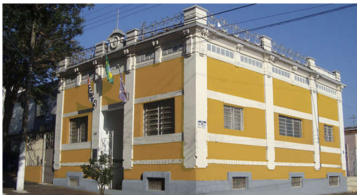
Figura 177 – Prédio da Antiga Subprefeitura
