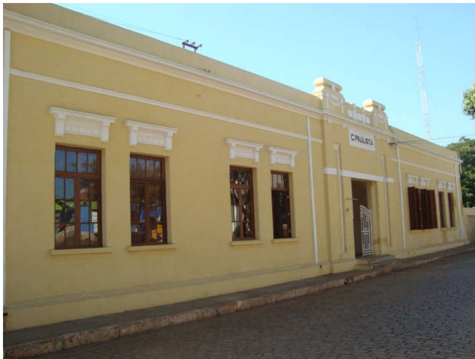
Figura 170- Fachada da Estação de Trem de Sumaré Fonte: Pró-Memória
