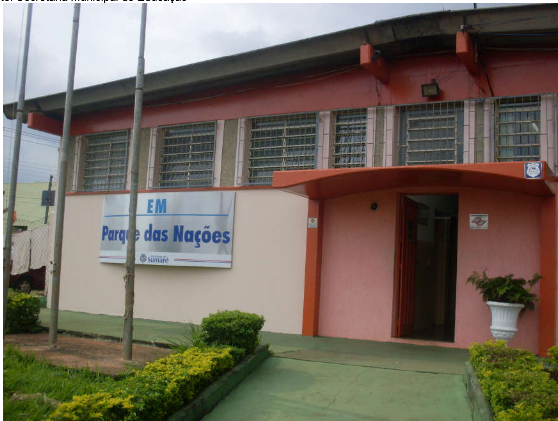
Figura 148 - EMEI Parque das Nações
