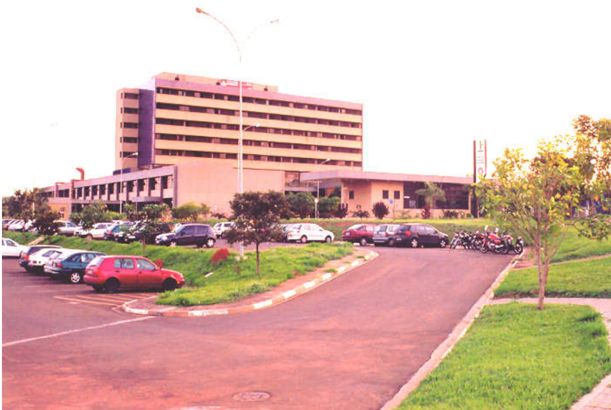
Figura 164 - Hospital Estadual Sumaré Dr. Leandro Franceschini
