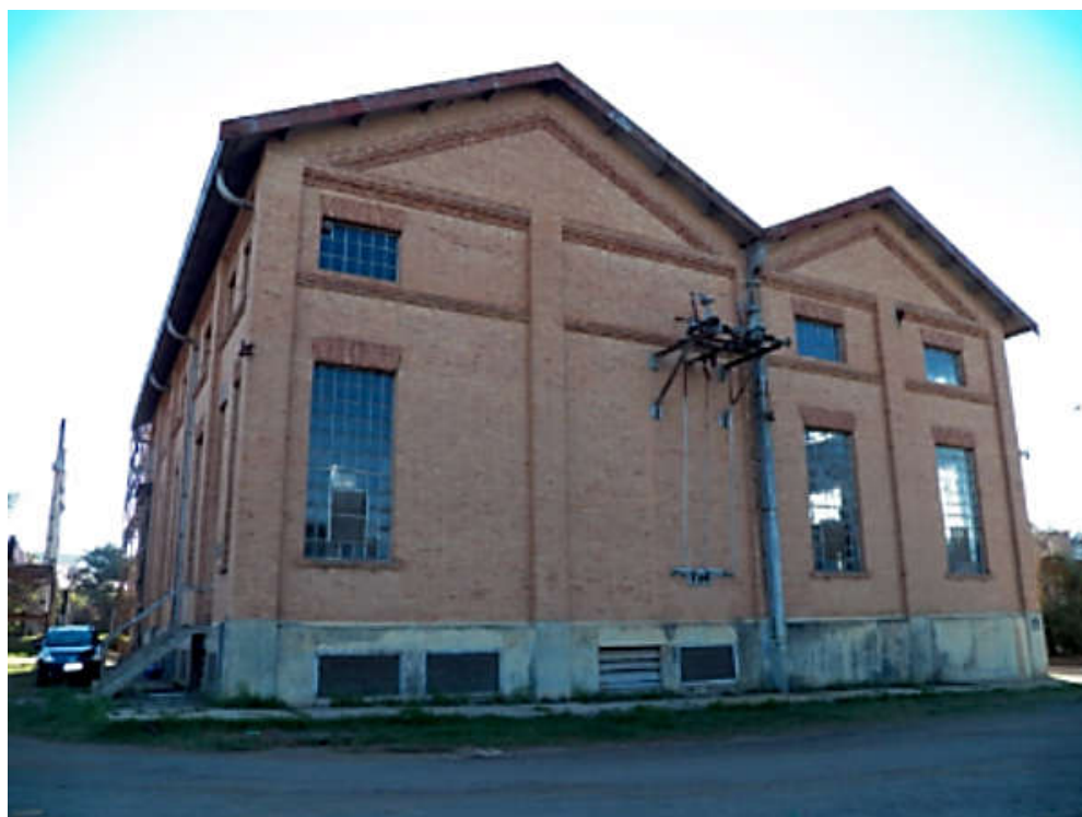
Figura 173 - Fachada da Subestação Fonte: Pró-Memória
